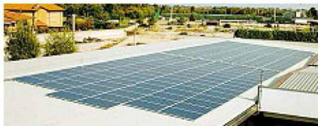
L'impianto fotovoltaico da 40kW che fornisce energia alla sede di Petalò
